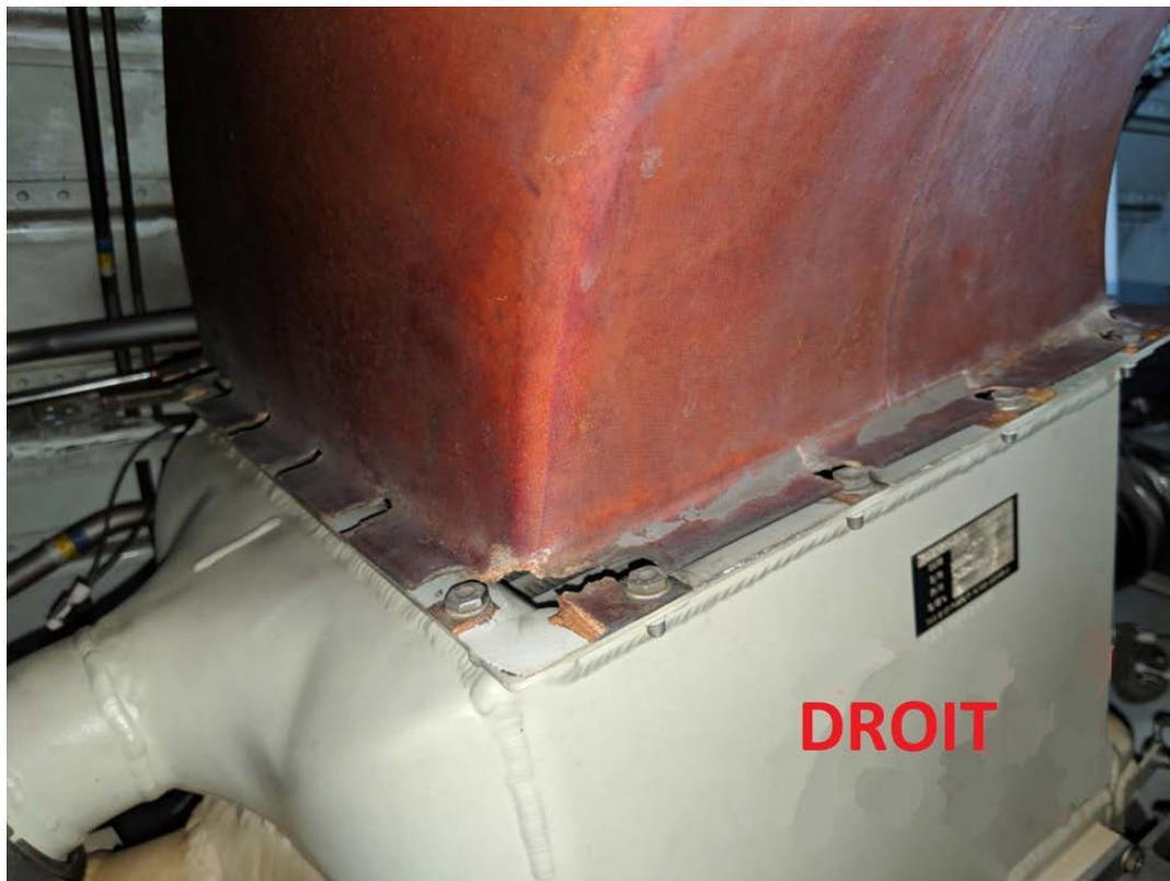
Fig 4 : Conduit droit interne et avant séparé de l'échangeur d'air
