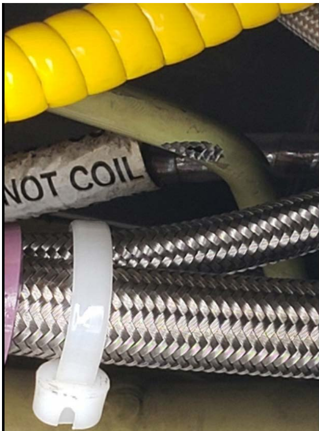
Usure par frottement de la conduite de remplissage d'huile
